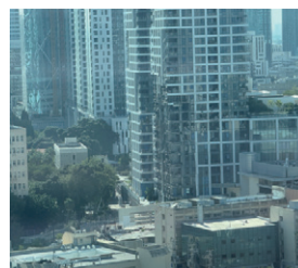
2025年6月、 イランのミサイル攻撃を受けたビル
